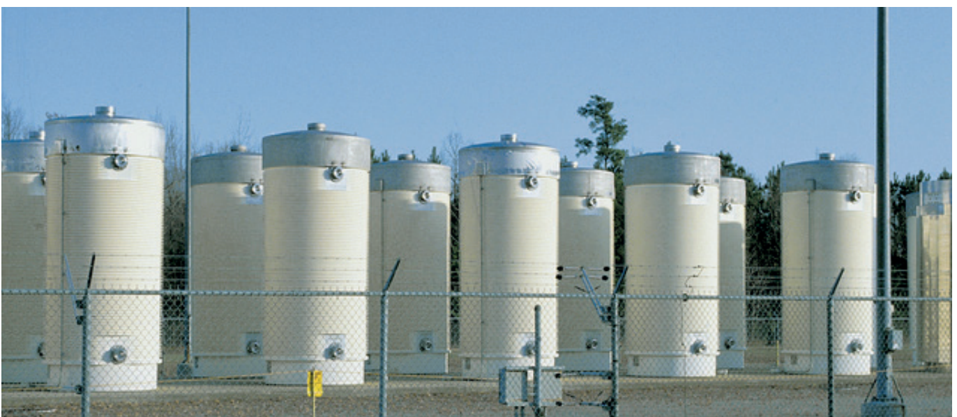
ตัวอย่างการจัดเก็บเชื้อเพลิงนิวเคลียร์แบบแห้ง (Dry Storage)
