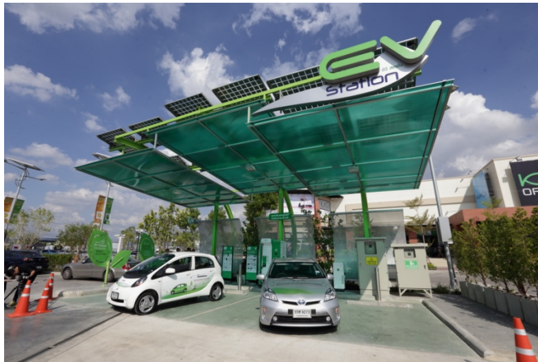
รูปที่ 4 สถานีอัดประจุไฟฟ้าในสถานีบริการน้ำมันครบวงจร PTT Greenergy Station ถนนชัยพฤกษ์
