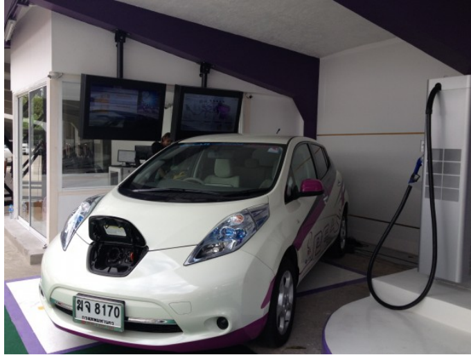
รูปที่ 5 สถานีอัดประจุแบบ Quick Charge ที่ใช้พลังงานจากเซลล์แสงอาทิตย์ของ กฟภ.
