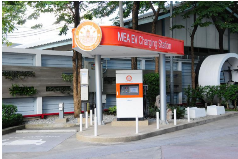
รูปที่ 3 สถานีอัดประจุไฟฟ้าแบบ Quick Charge ที่ติดตั้งในสำนักงานใหญ่ กฟน. ชิดลม
