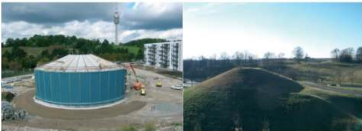
รูปที่ 4.78 : Underground TES
