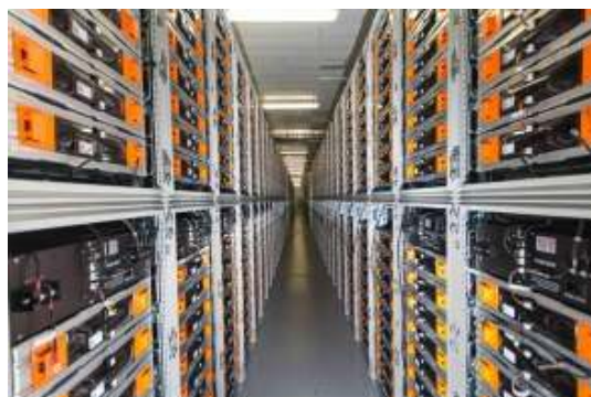
รูปที่ 2.112 : โครงการ Tehachapi Wind Energy Storage ที่มลรัฐแคลิฟอร์เนีย
