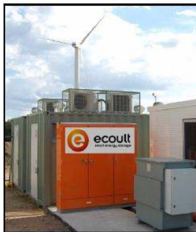
รูปที่ 4.38 : ระบบอัจฉริยะ Ecoult UltraBattery โครงการ Hampton Wind Smoothing ในประเทศออสเตรเลีย
