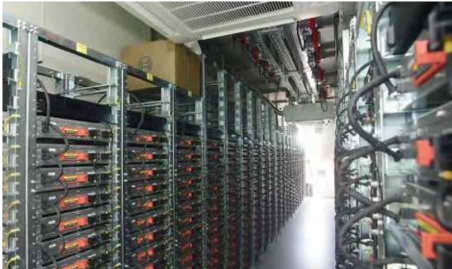
รูปที่ 2.130 : แบตเตอรี่ลิเทียมไอออน และ Vanadium redox flow ในโครงการที่ Braderup
