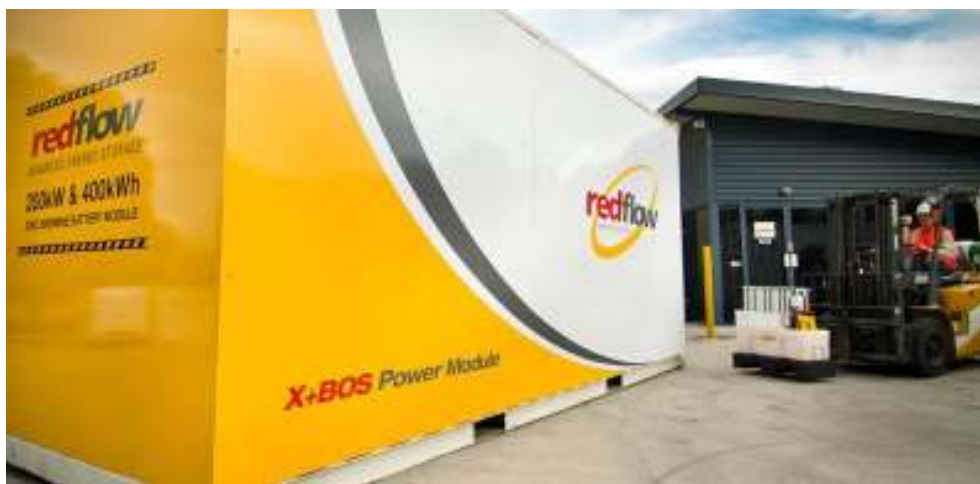
รูปที่ 4.63 : แสดงตัวอย่างแบตเตอรี่สังกะสี-โบรมีน ขนาดใหญ่ 200 kW สำหรับใช้งานกับในระบบสายส่งไฟฟ้า
