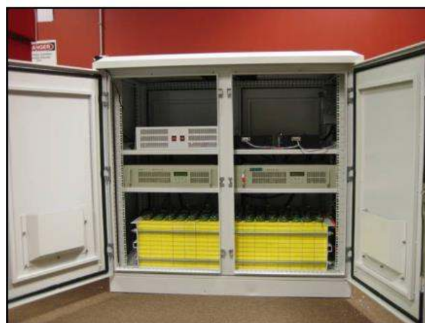
รูปที่ 4.42 : ระบบ 6 kW/ 20 kW h กับระบบควบคุมและ Inverter โดยหน่วยงานการจัดการด้านพลังงานของ GreenSmith (EPRI, 2010)
