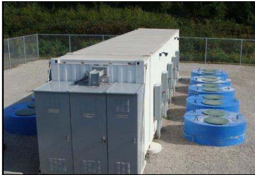
รูปที่ 4.9 : การประยุกต์ใช้ล้อยุนกำลังขนาด 1 MW/15 นาที ของ Beacon Power ในการบริการช่วยเหลือผู้ทำงานของระบบอิสระ (EPRI, 2010)
