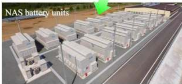
รูปที่ 2.161 : โครงการติดตั้งแบตเตอรี่ NAS เพื่อควบคุมกำลังผลิตจากโรงไฟฟ้าพลังลมที่ Futamata
